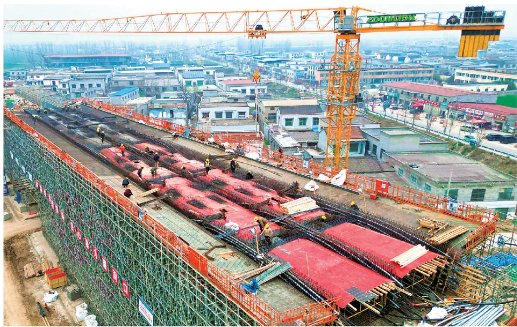
3月14日上午,中铁十局工人在平周高铁9标段工地上开展岔道连续梁施工。
